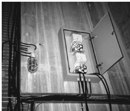
monitoring Dubrovačkog mosta
