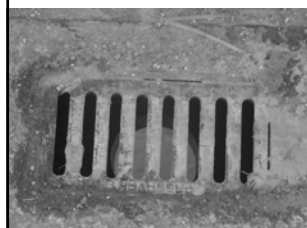
vertikalni slivnik nakon ugradnje
