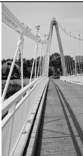
primjer metalne ograde pješačkog mosta – oграда je pod nagibom zbog nagnutih vješaljki
