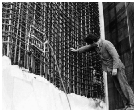
monitoring Masleničkog mosta
